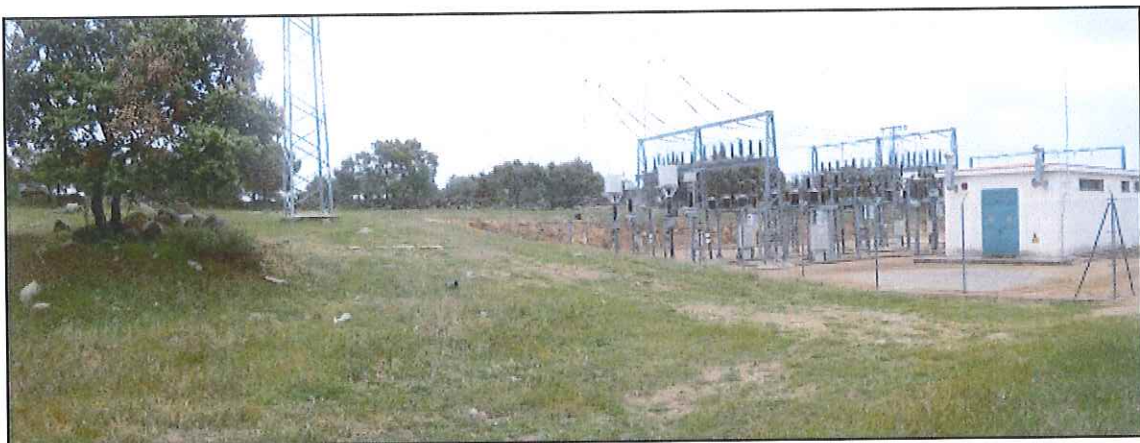
Figura 11. Entrada del trazado del tendido en la Subestación de Burguillos del Cerro, sobre dehesas con pastizal.
